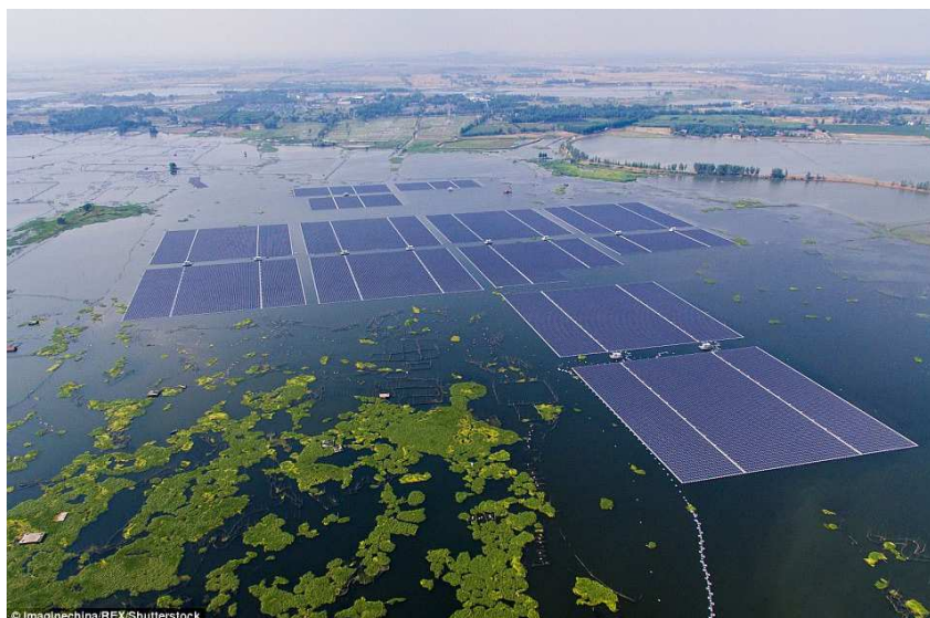
Figura 2 – Módulos fotovoltaicos flutuantes instalados na usina Sungrow localizada em Anhui, China.
